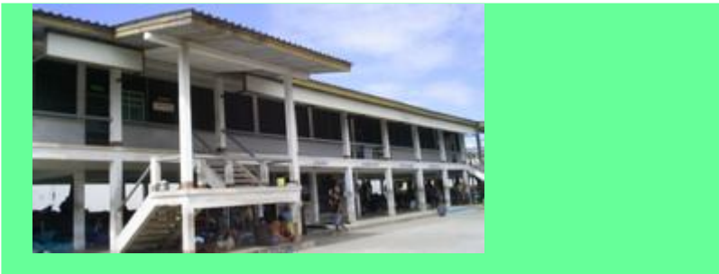
เรือนนอนคอนกรีต เสริมเหล็ก สร้างปี พ.ศ. 2525
