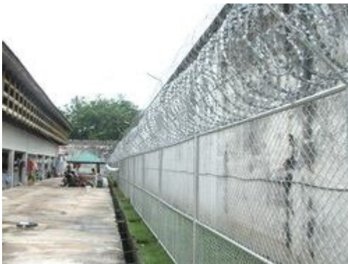
แนวกันกำแพงตาข่ายเหล็ก มีลวดหนามหีบเพลงด้านบน ด้านทิศตะวันตก
