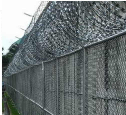
แนวกันกำแพงตาข่ายเหล็ก มีลวดหนามหีบเพลงด้านบน ด้านทิศใต้
